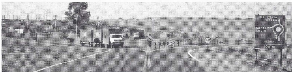
Figura 9: Acesso a Sta. Lúcia – RFPP “depois”, deflexão que obriga a redução da velocidade.
