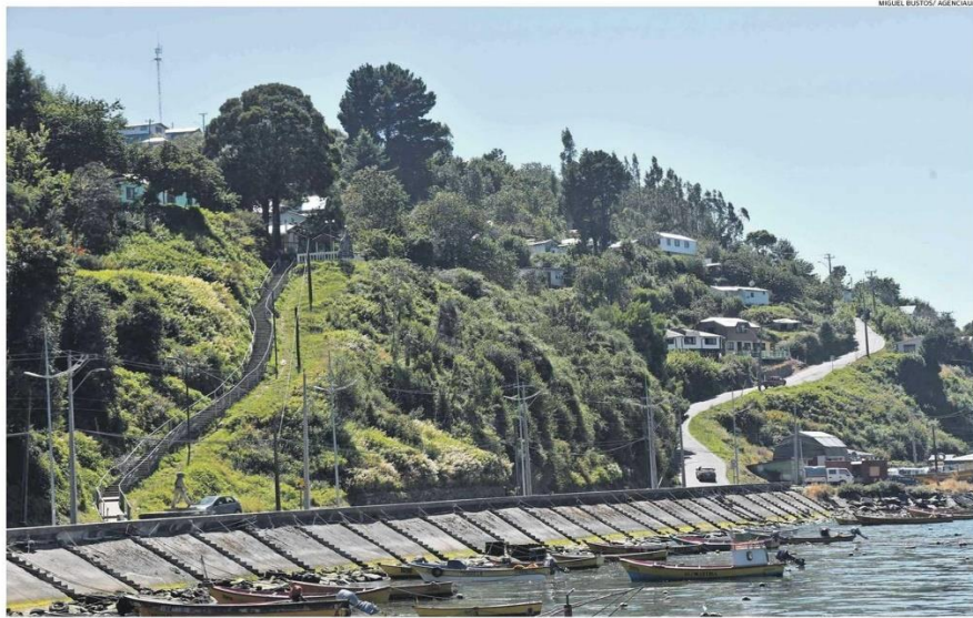
HOY LOS ELEMENTOS DE MOVILIDAD PEATONAL EN LOS CERROS DE LA COMUNA SON PRECARIOS, EXISTEN PAVIMENTOS DETERIORADOS, DISCONTINUIDADES, FUERTES PENDIENTES Y FALTA DE CONEXIÓN.
