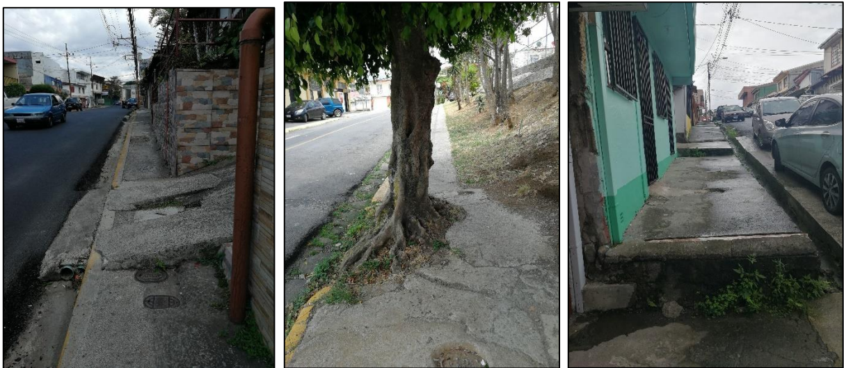
Figura 3. Obstáculos como árboles, gradas, accesos vehiculares y anchos insuficientes, zona de influencia Rotonda Betania
