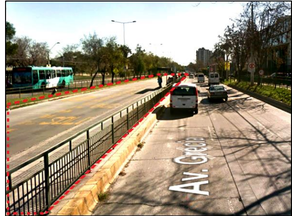
Figura 2: Corredor de buses de Av. Grecia Fuente: Google Street View.
