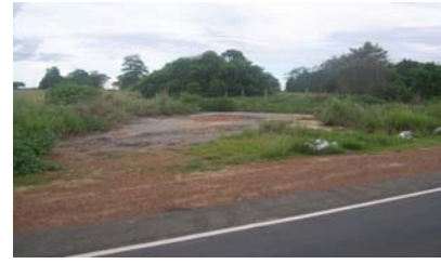
Figura 5. Canteiro de obras abandonado promovendo um passivo ambiental na readequação da rodovia
