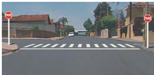
Figura 17- Faixa de pedestre + linha de retenção.
